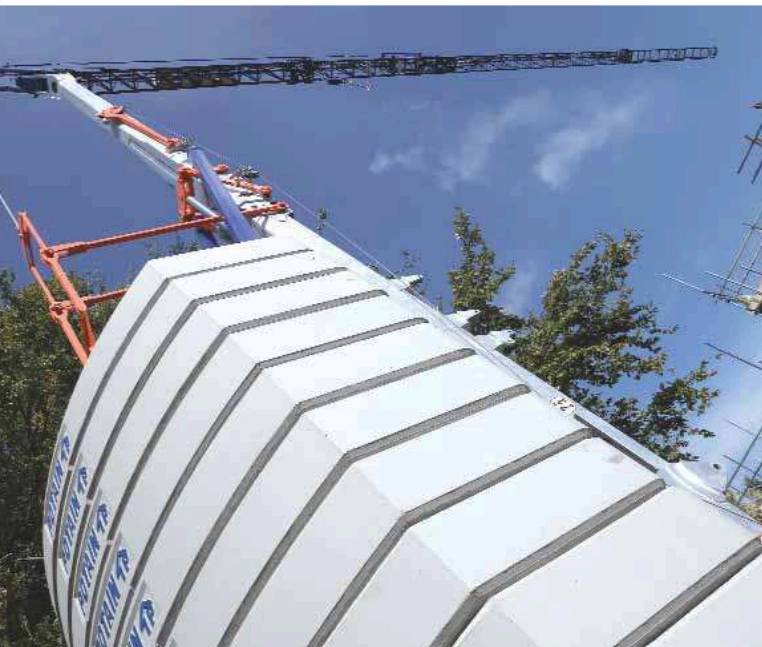
Die Selbstmontagekrane von Potain werden in Großbritannien immer beliebter.
