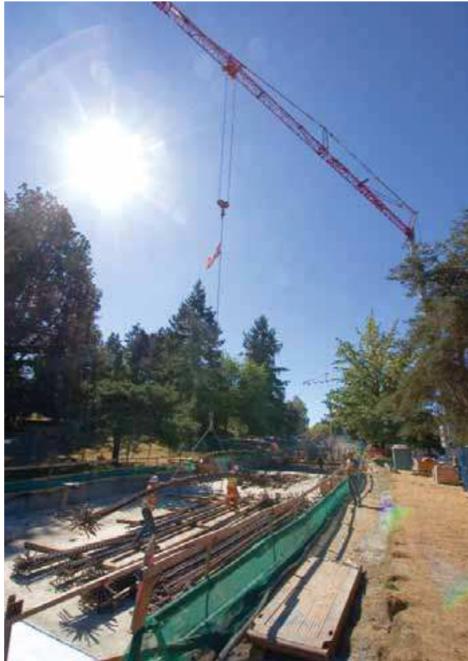
Bei dieser Baustelle war es unerlässlich, die Bäume mit genügend Abstand zu umfahren.
